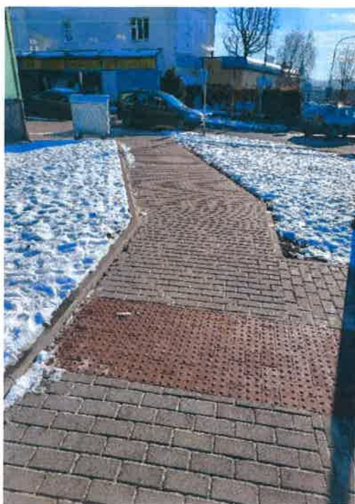
Ulice Fugnerova -subdodavatel
